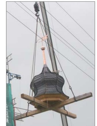
Aufsetzen der Turm-Zwiebelhaube
