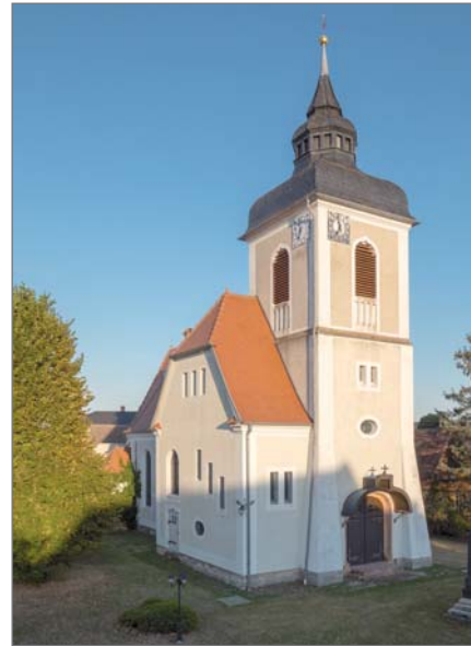
Turm mit Eingang, von Westen gesehen
