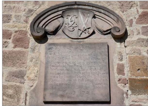
Wappen aus Sandstein über dem Eingangsportal
