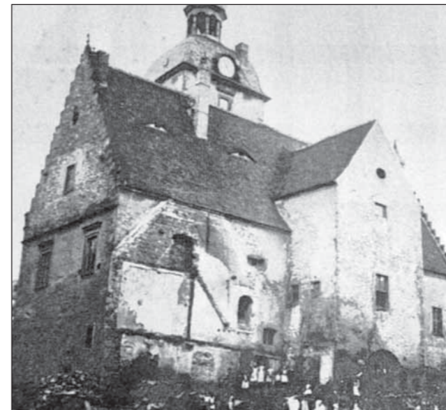
Rathaus - 1896, Abriss Anbau
