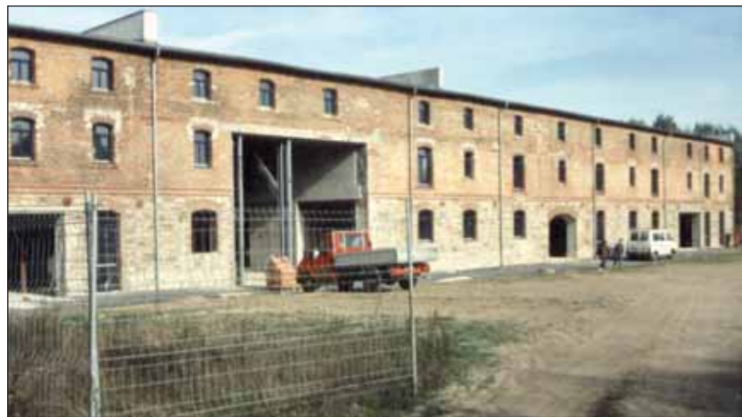
Vorderansicht des ehemaligen Schafstalls während des Umbaus
