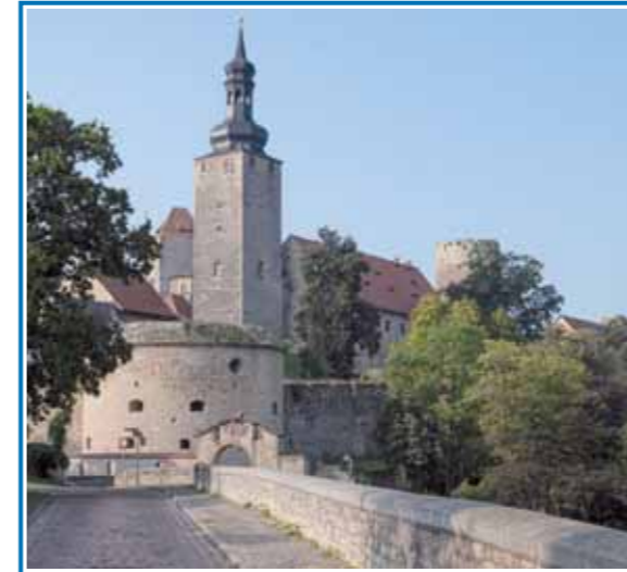
Burg Querfurt Osttoranlage und Westseite- 2021
