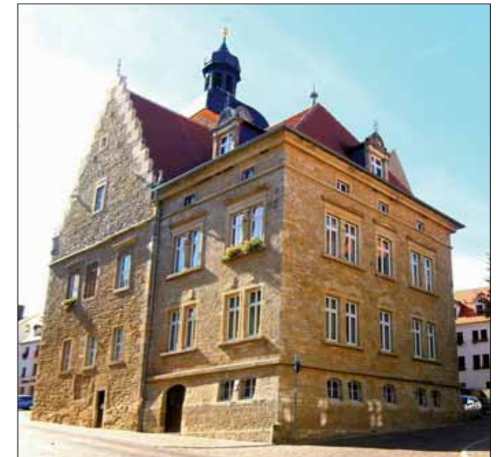
Rathaus Nordseite- 2020, Anbau von 1890
