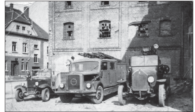
Feuerwehrfahrzeugpark, Merseburger Straße 1938
