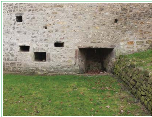
Zugang in die Südostbastion (2)
