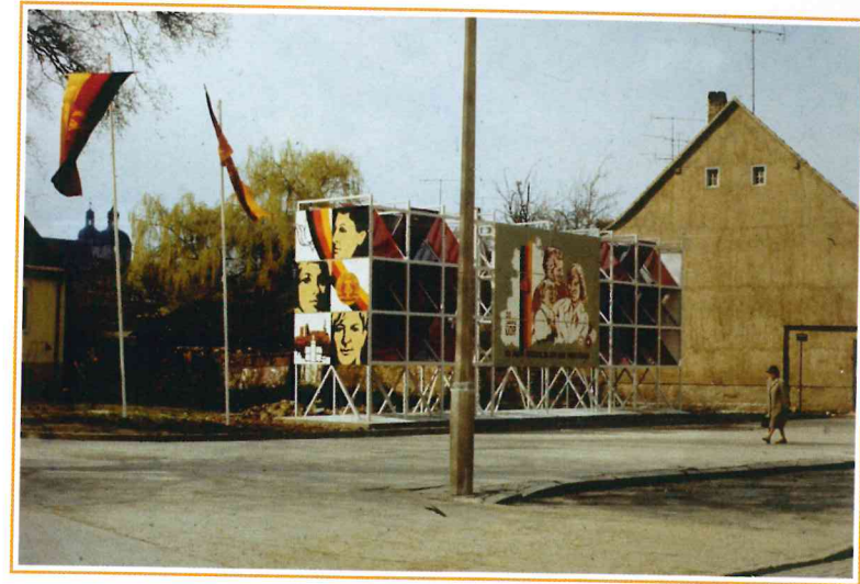
Metallkonstruktion neben dem „Einrichtungshaus“ – 1979
