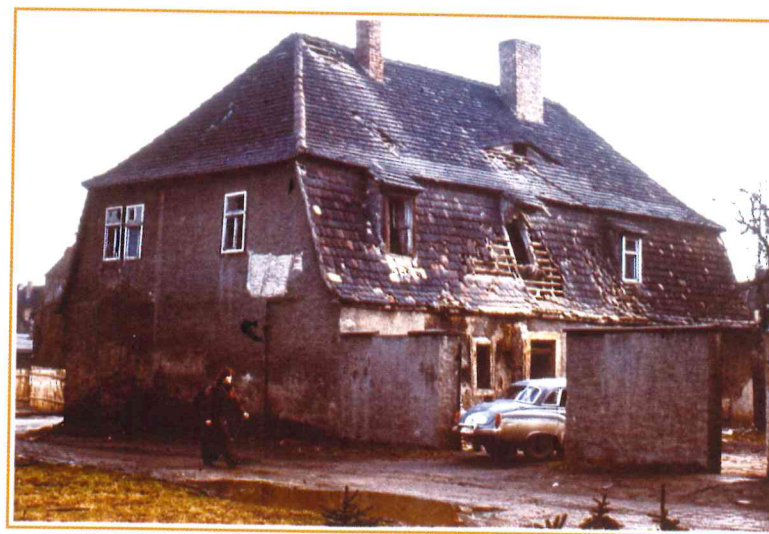
Ehemalige Salpeterhütte kurz vor ihrem Abriss – 1979
