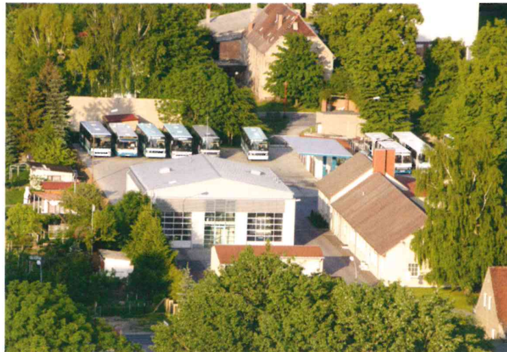
Betriebshof Querfurt mit neuer, moderner Waschanlage - 2004
